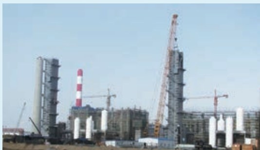
空分施工现场
